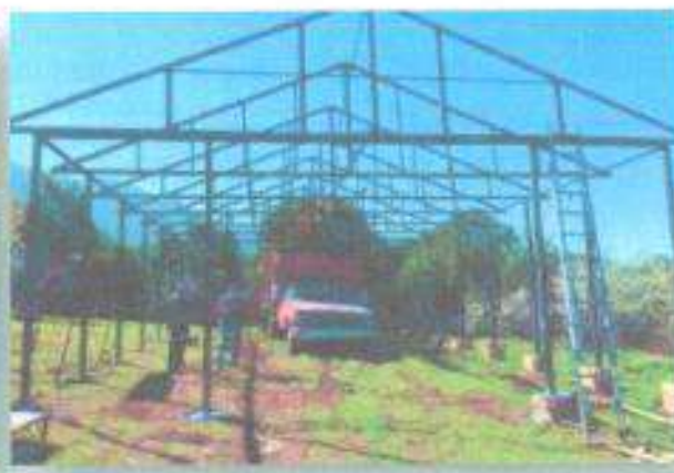
INICIO CONSTRUCCIÓN DE BODEGA
